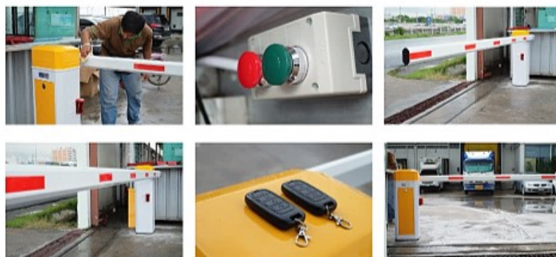
ภาพตัวอย่าง การติดตั้งระบบรักษาความปลอดภัย
