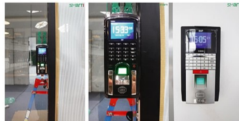
ภาพตัวอย่าง การติดตั้งระบบรักษาความปลอดภัย
